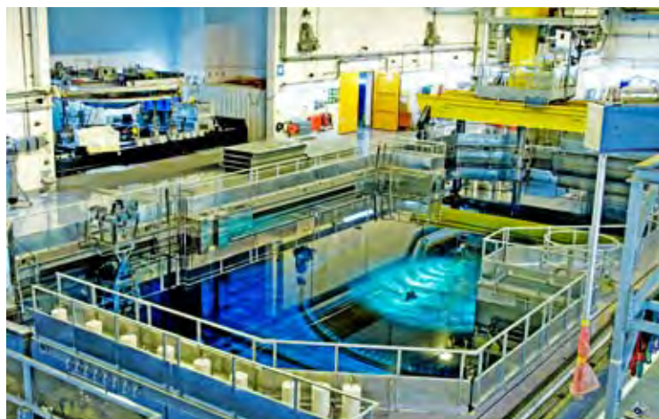
Reaktorhall på Forsmark 3. I bassängen syns toppen av reaktorinneslutningen, kupolen.
