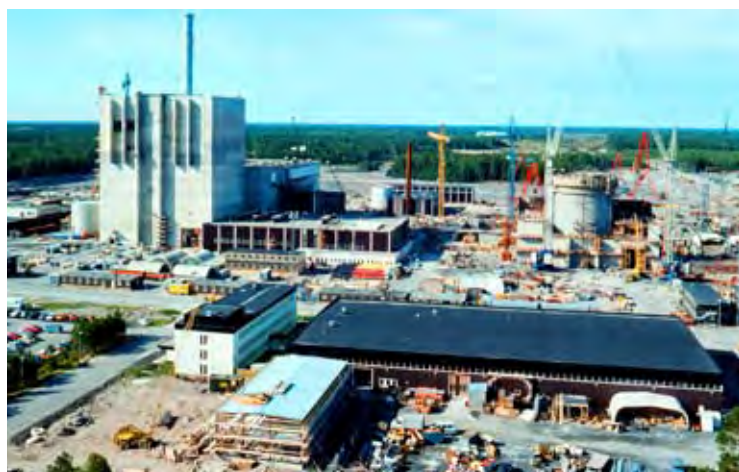
Forsmark 1 och Forsmark 2 under uppbyggnad i slutet av 1970-talet.
