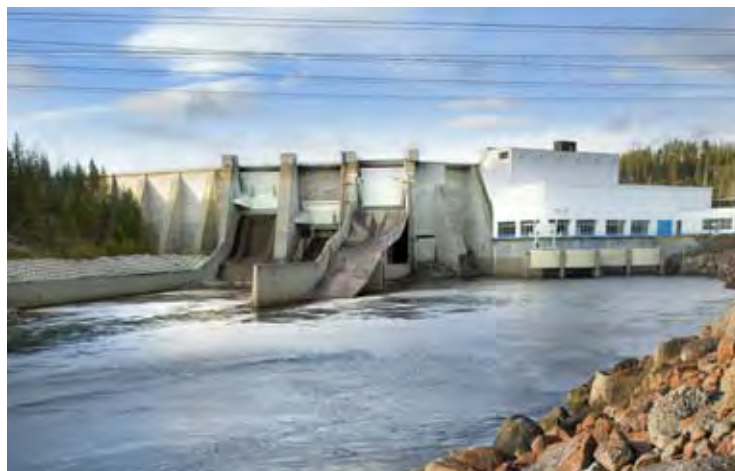
De flesta vattenkraftverk byggdes på 1940- och 50-talet och finns i Sveriges norra delar. Här ser vi Tuggen vattenkraftverk i Lappland.
